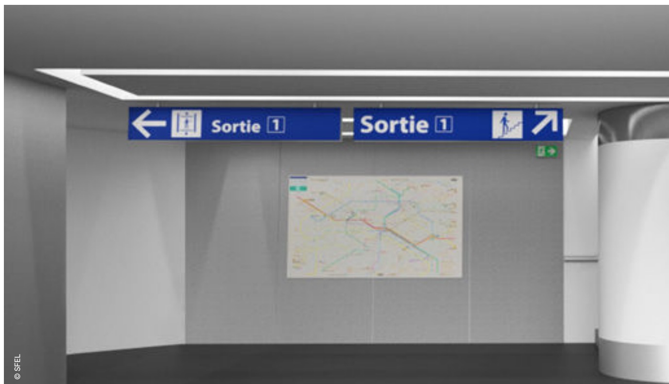
Montage par le dessous en gorge , système installé dans le faux-plafond. Couloir, lieu de passage des voyageurs.
